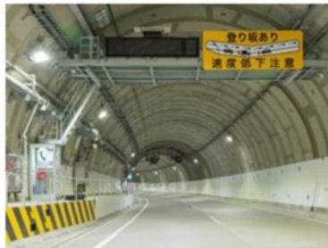
大和川第三トンネル
