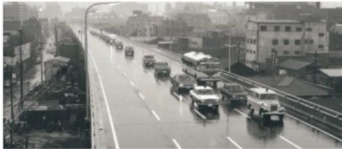
1号環状線 四ツ橋付近
