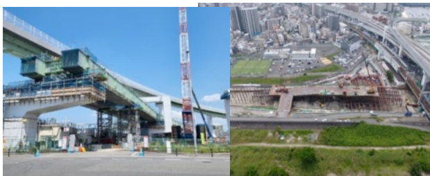
淀川左岸線 (2期) 建設中
